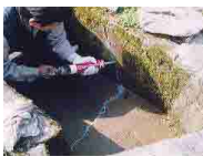
水路のひび割れ補修
