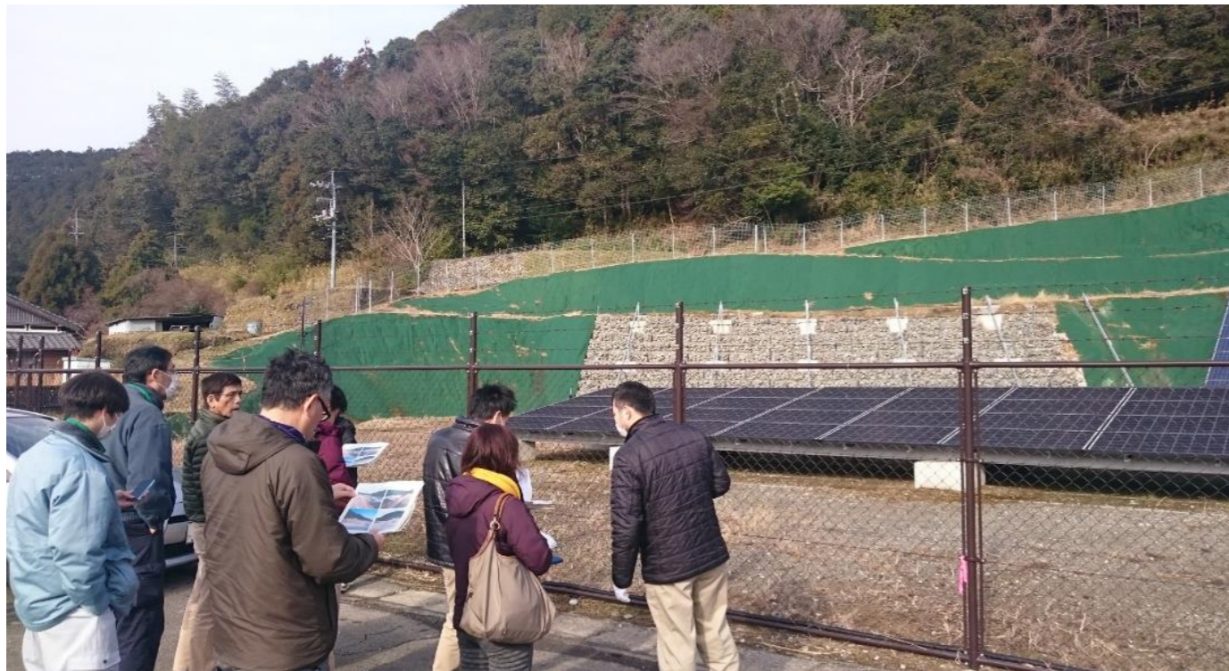
【事例】2 秋丸地区 太陽光発電施設
