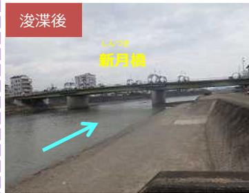
河床掘削による流下断面の確保
