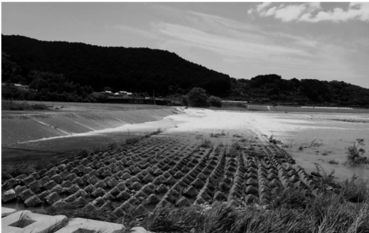
令和5年5月8日 統合堰(町田堰)
