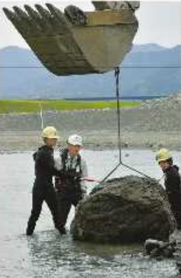
物部川復旧工事の現場。左側は旧河道、右側は新河道。新河道は「近自然工法」で造成された。写真：NHK
