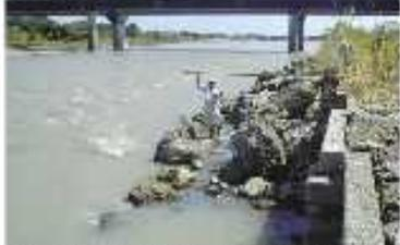
物部川復旧工事の現場。左側は旧河道、右側は新河道。新河道は「近自然工法」で造成された。写真：NHK
