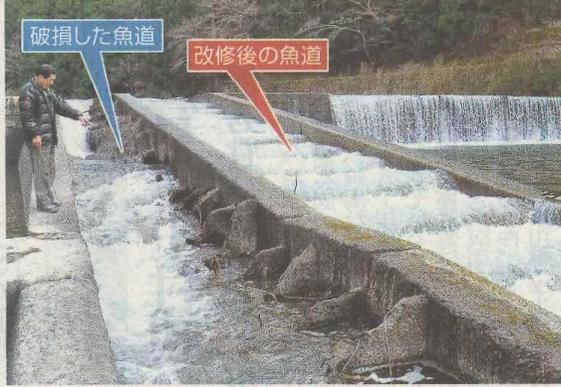
安田川砂防ダムの中央にある2本の魚道。右側は3年前に改修された。左側は隔壁が流失している。長い傾斜の急流で魚が休む場所もなく、遡上は難しい(安田町与床)
