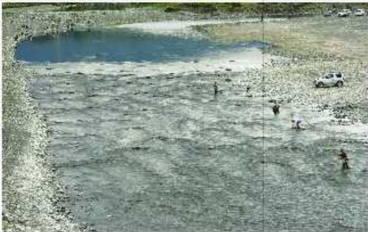
物部川復旧工事の現場。左側は旧河道、右側は新河道。新河道は「近自然工法」で造成された。写真：NHK
