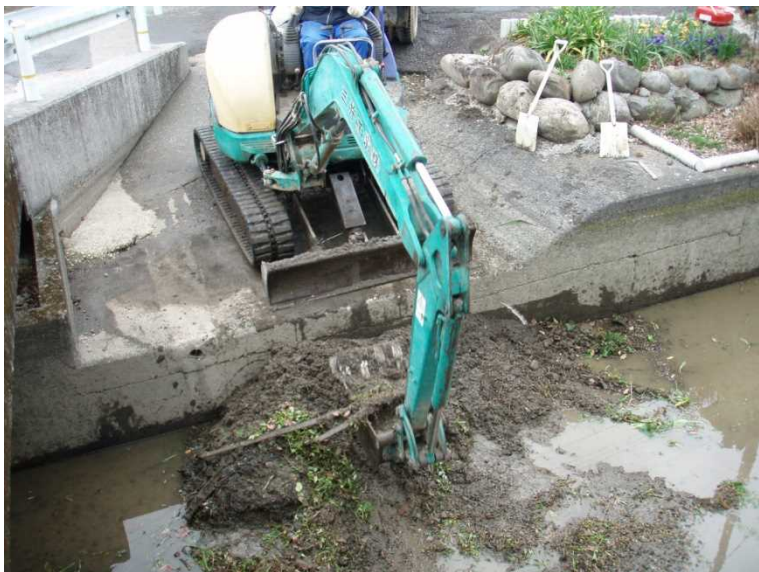
業者による浚渫作業(中井筋)
