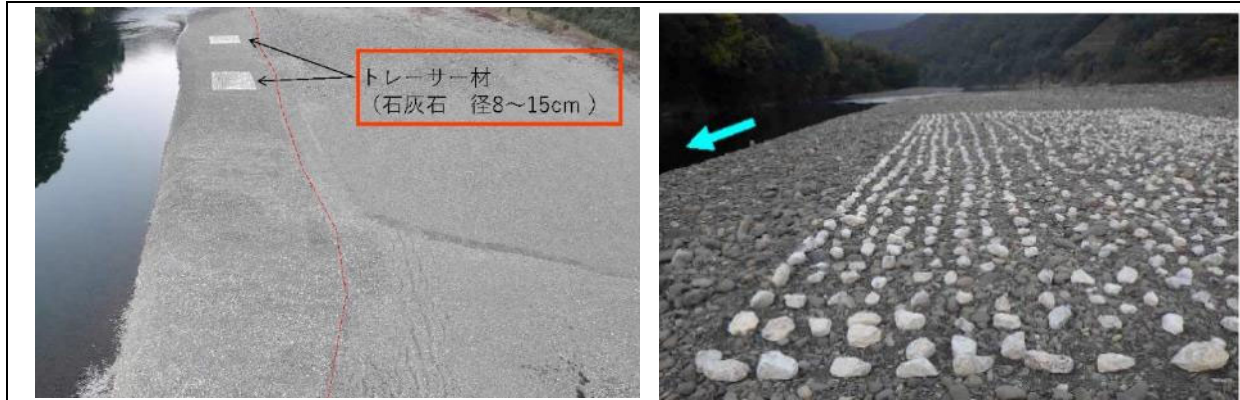
図 1.3.2 試験施工（置土）R6 年（2024 年）10 月～11 月
