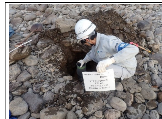
採水孔設置状況
