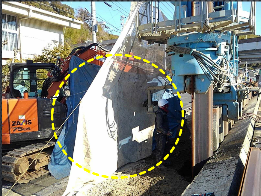
ブルーシートの設置
