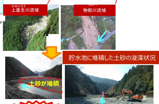
貯水池に堆積した土砂の浚渫状況
