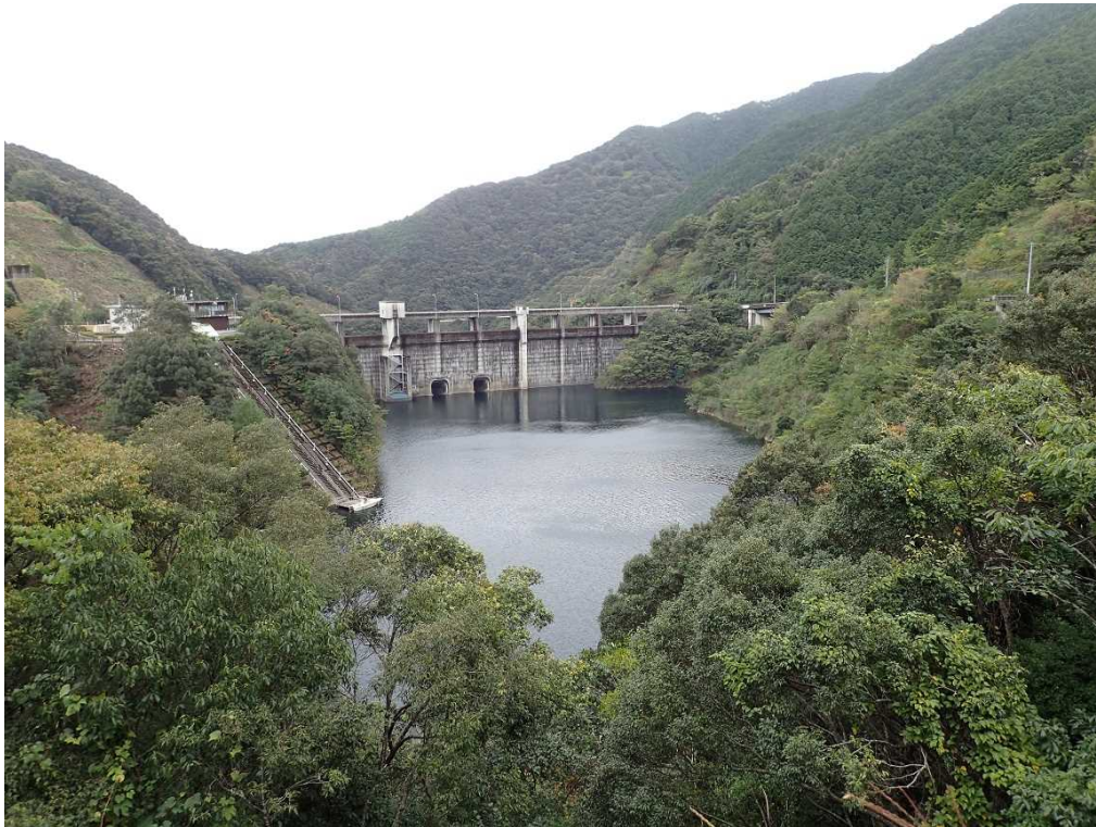
（ダム直上流状況）
