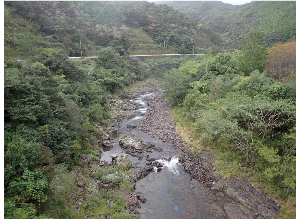
（ダム上流状況）
