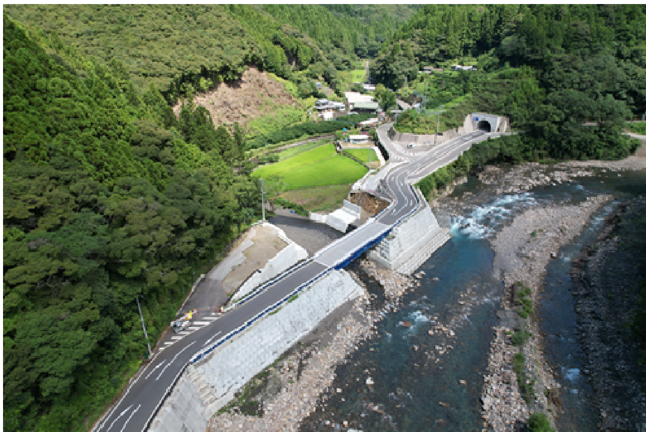
主要地方道安田東洋線（安田町）
