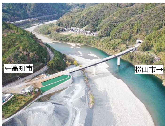
高知松山自動車道 越知道路(2工区) (横倉大橋)
