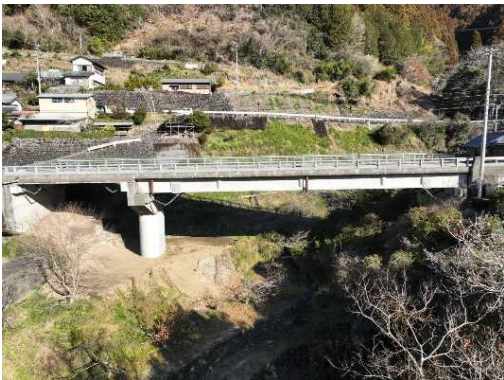
（国道195号 塩橋 香美市物部町）
