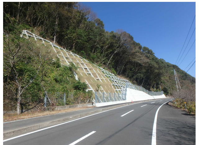
(県道安満地福良線 大月町)
