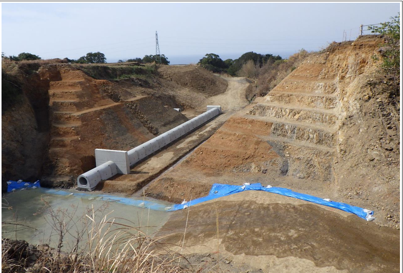
ため池改修工事(甚太ヶ鼻池) 底樋 \phi 800 L=36.0m 工事用道路 1.0式
