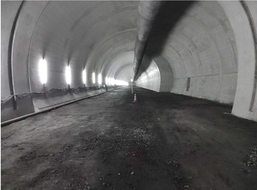
施工延長 L=1416m トンネル工(NATM) L=1416m
