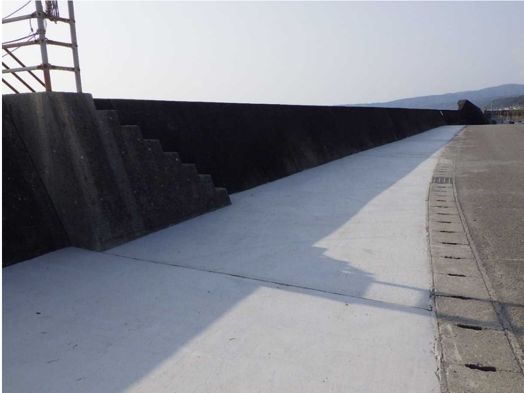
D護岸 コンクリート舗装工 A=336m 2 臨港道路 排水構造物工 L=72m 沖防波堤 係船環工 N=13基 F護岸 飛石防止柵工 L=56m
