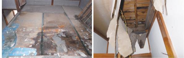
雨漏りにより畳も天井もボロボロに……
