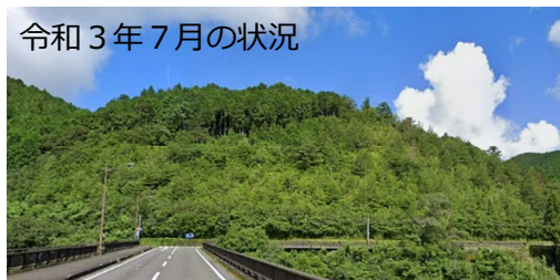
県道窪川船戸線一斗俵工区（四万十町）
