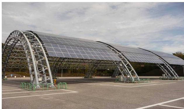
太陽光発電システム (のいち動物公園)
