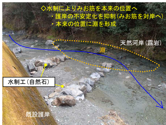
着工前(狩山川:仁淀川町見ノ越) 水制設置箇所(工事完了直後)
