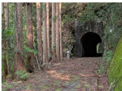
「オオムカエ隧道」
