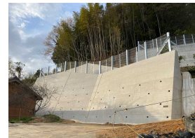
【野久保地区】 (急傾斜地崩壊対策施設の整備)
