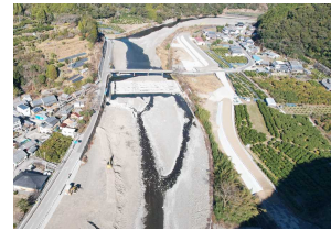
【安芸川】 (河川の堤防整備)
