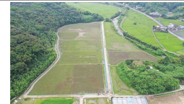
【加持地区(黒潮町) ほ場整備】
