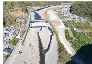
【安芸川】 (河川の堤防整備)
