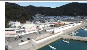
海岸堤防の耐震対策
