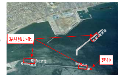
高知港防波堤の整備
