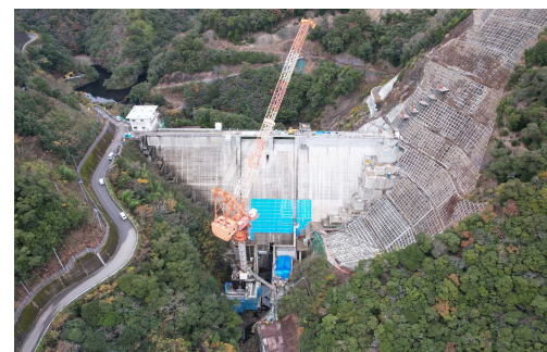
和食ダム建設
