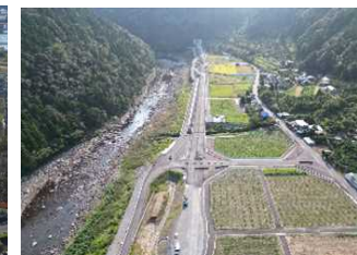
国道493号 (北川道路2-2工区)
