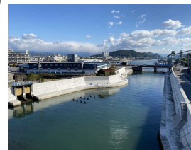
海岸堤防の耐震対策
