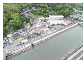
河川堤防の耐震対策
