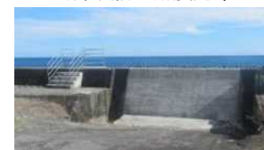
コンクリートによる陸こうの閉鎖
