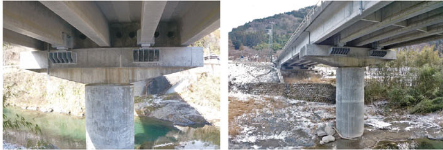
国道197号 北川2号橋(津野町)
