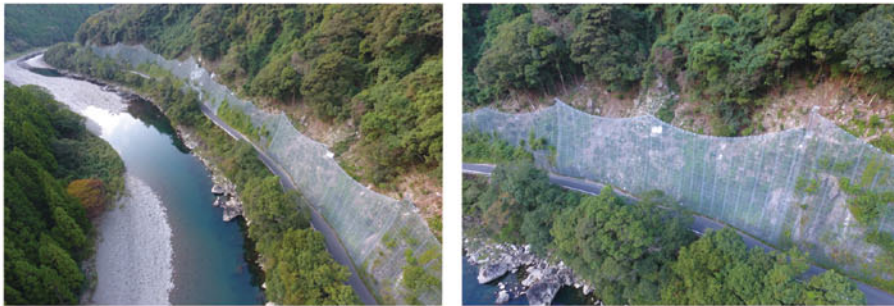
国道493号(安芸郡北川村)
