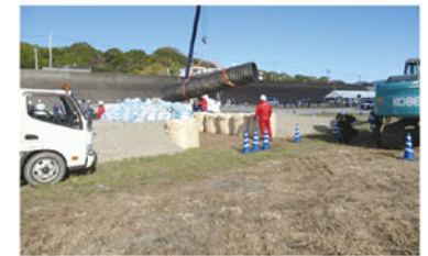
▲ 仮設道路の設置
