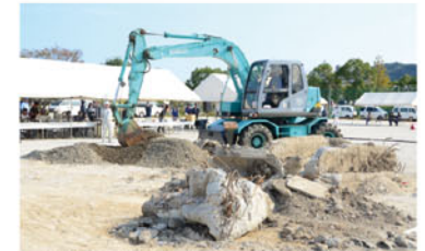
▲ 通行の妨げとなる土砂の撤去
