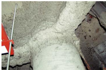
柱や梁に施工 吹付け石綿
