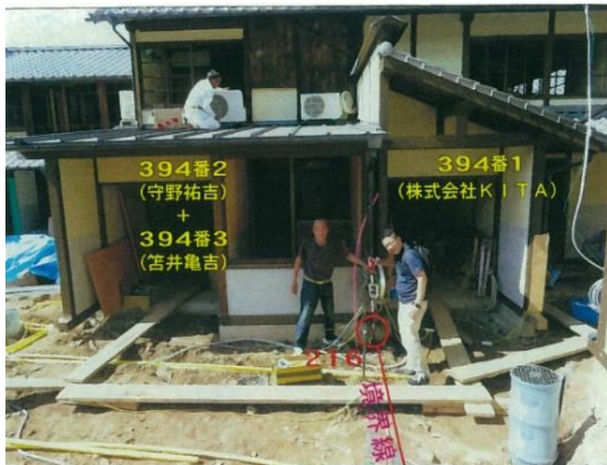
建物基礎コンクリートの角
