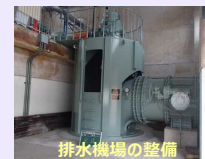
排水機場の整備
