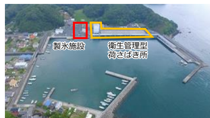
▲製氷施設等の増設を進めている田ノ浦漁港（宿毛市）
