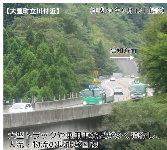
【下り線を活用した対面通行による通行再開状況】
