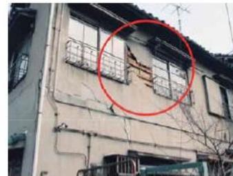
【半壊】塗り壁では仕上の大半が剥離・脱落
