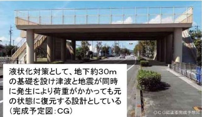
液状化対策として、地下約30mの基礎を設け津波と地震が同時に発生により荷重がかかっても元の状態に復元する設計としている（完成予定図：CG）
