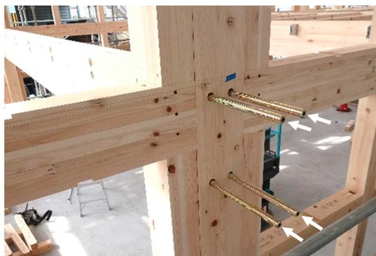
図6 GIR接合部（柱-梁）の施工状況
