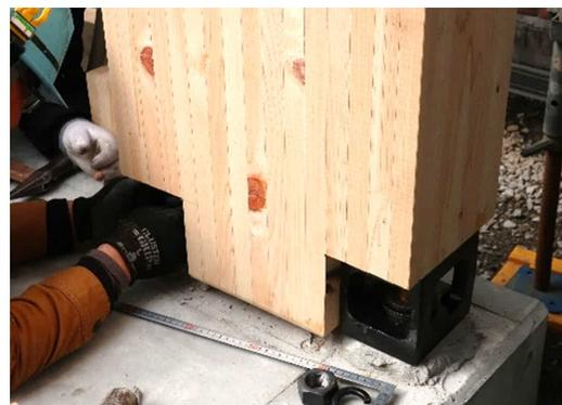
図5 GIR接合部（柱脚）の施工状況
