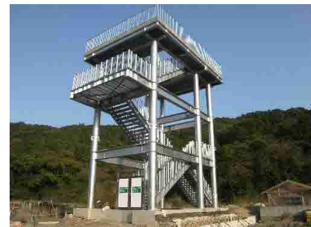
津波避難タワー(四万十町)
