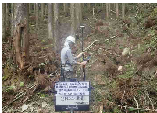
測量作業の様子
