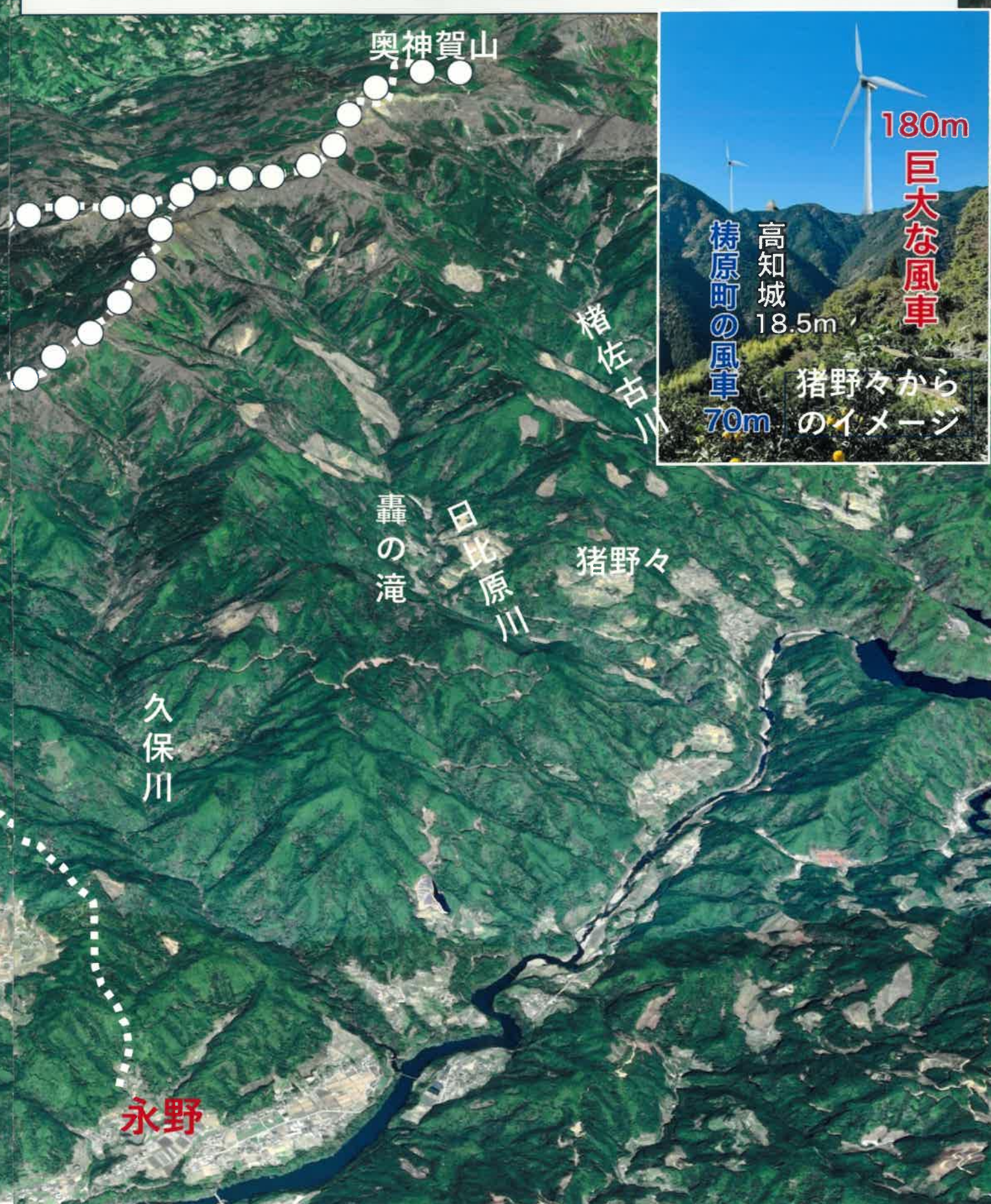
谷相上部をアクセス道路が延び、奥神賀山に至る稜線部
