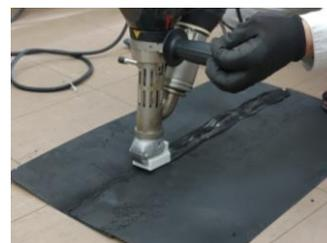
押出し式熱溶接による遮水シートの接合
