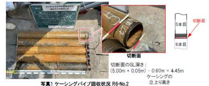
鋼管（ケーシングパイプ）破断状況
