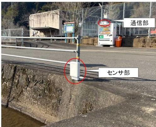
写真11-4 浸水センサ設置事例（西田地区）
