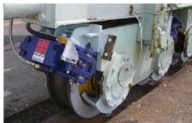
逸走装置の設置
