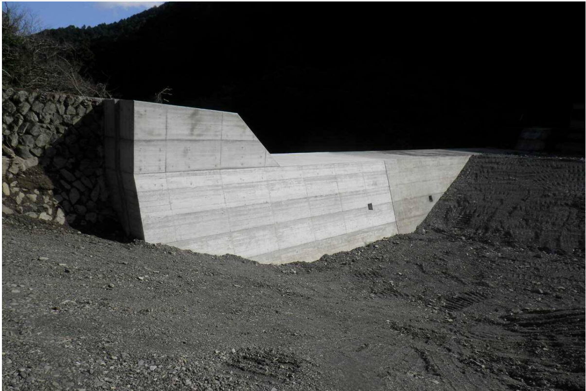
堰堤腹付け工 本堤コンクリート L=13.0m V=161m 3
