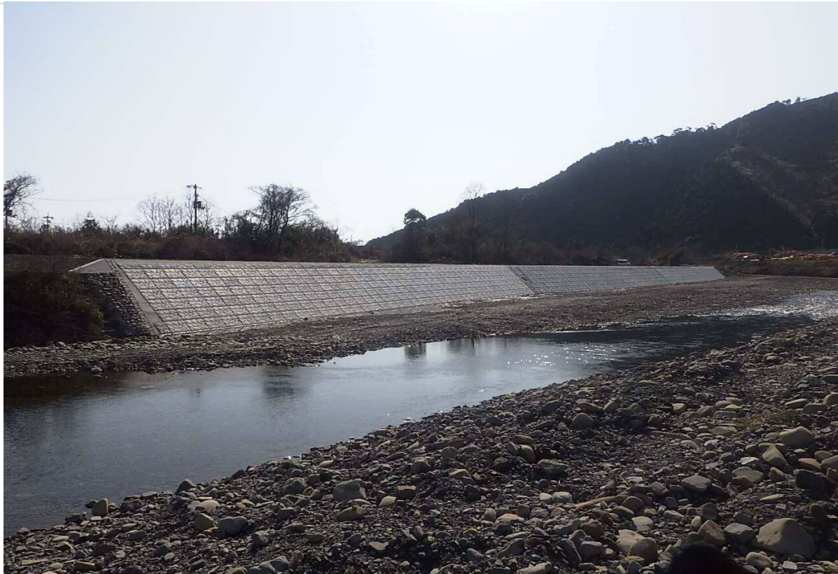
復旧延長 L=156.4m ブロック張(景観)A=1125m 2 仮設道路 L=172m
