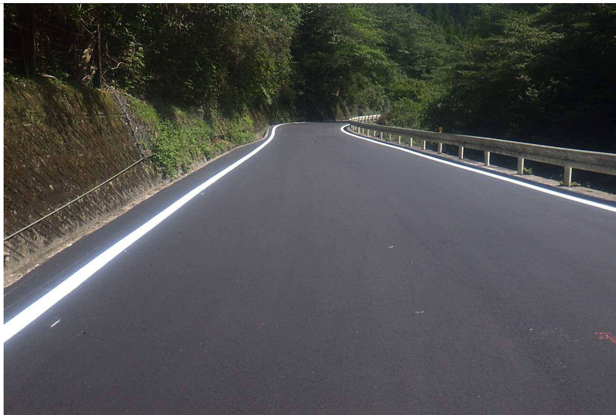
舗装修繕 L=290m 路上再生路盤工 A=1260㎡ 表層打換え A=1870㎡
