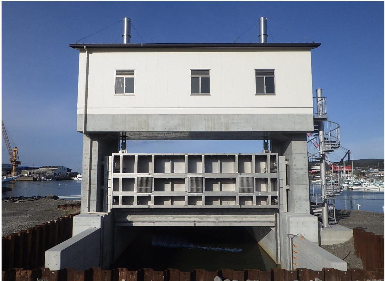
ステンレス鋼製ローラーゲート 1門（純径間 10.0m×有効高3.3m）
