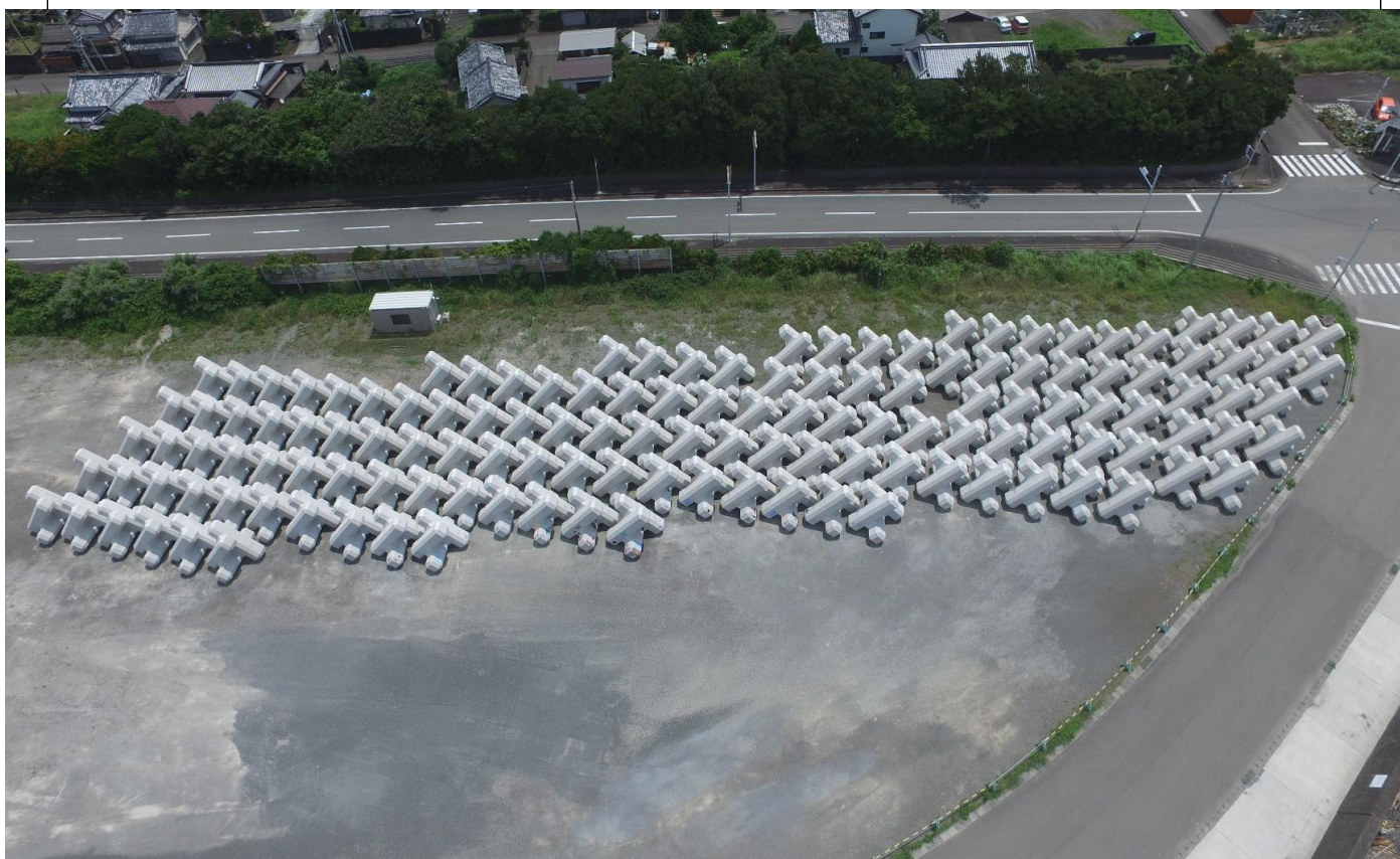
A防波堤 消波ブロック25t製作N=136個
