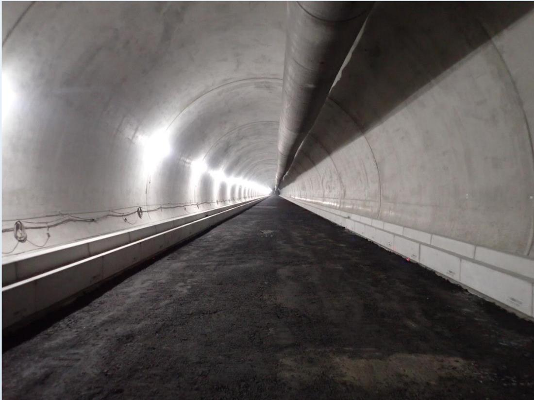
覆工コンクリートの養生方法は多数開発されているが、その中から施工性・経済性を考慮し保水養生テープを選定。
