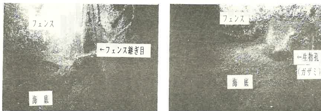
図4.6 シートの継目と生物孔
