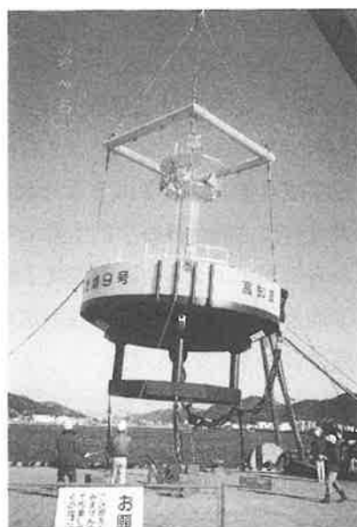
写真4 取付け状況（黒牧9号）
