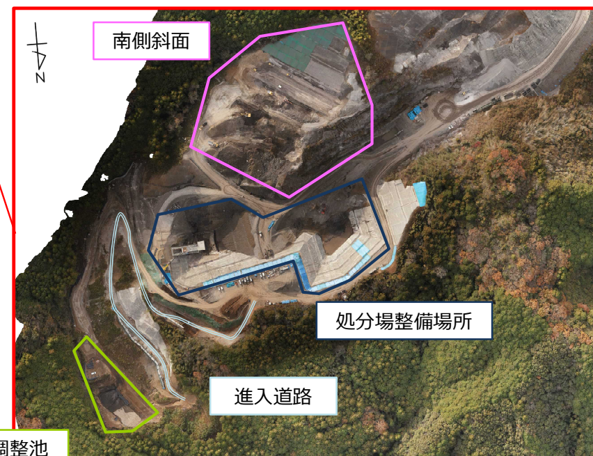
施設本体工事（空中写真、令和6年12月撮影）
