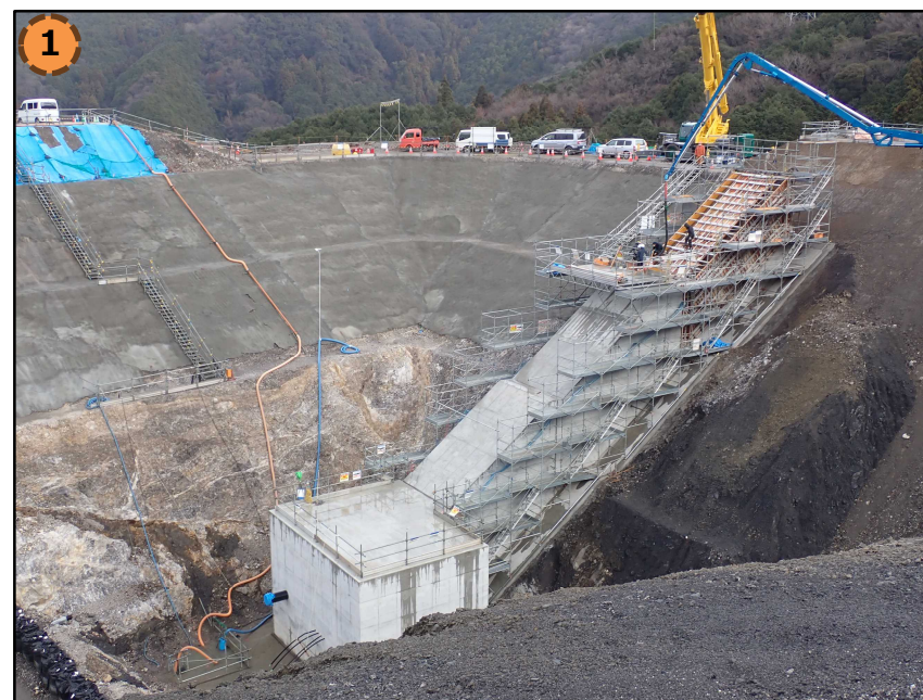
処分場東側の集水ピット整備状況（令和7年1月9日撮影）
