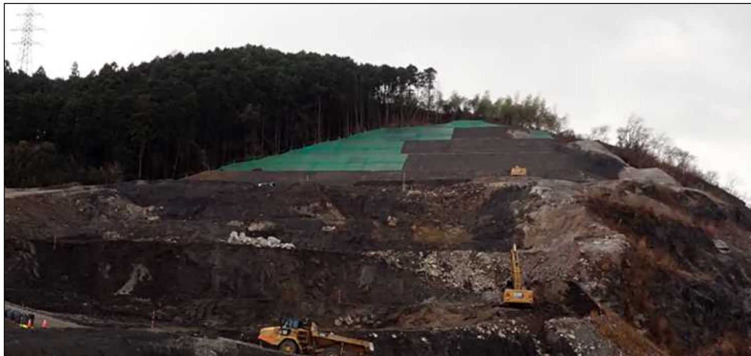
南側斜面の整備状況（令和7年1月9日撮影）
