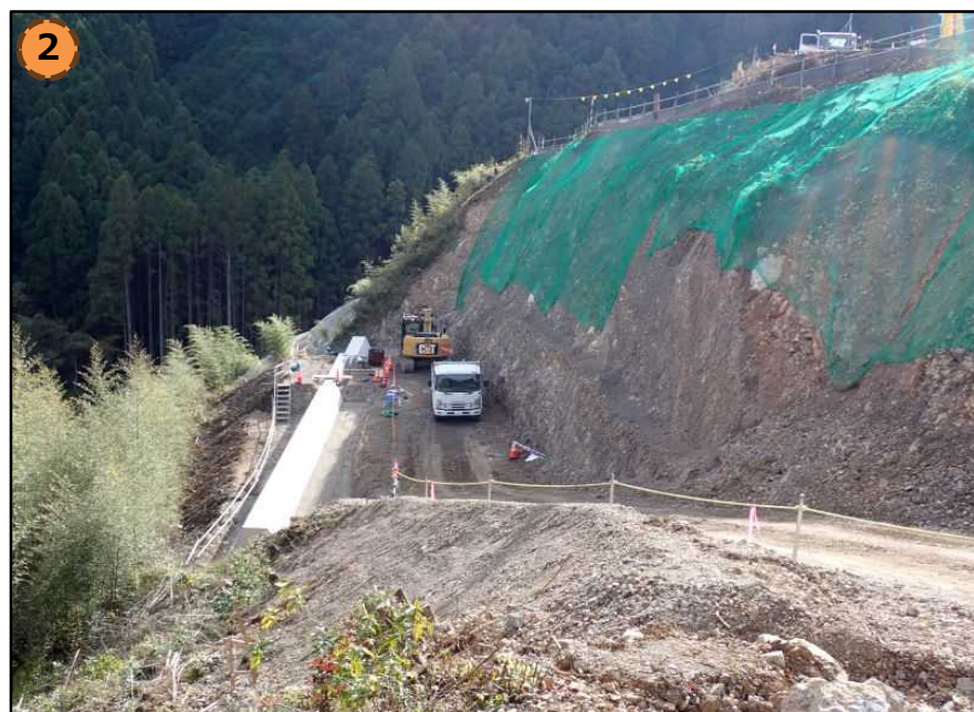
進入道路（施設本体側）の整備状況（令和6年12月12日撮影）
