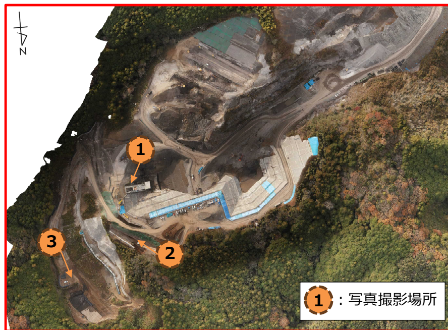
施設本体工事（空中写真、令和6年12月撮影）
