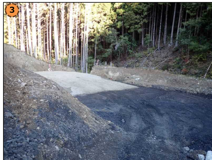
防災調整池の基礎部の施工状況（令和6年12月12日撮影）
