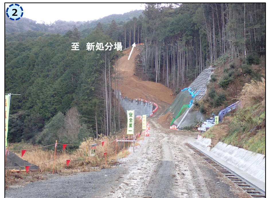
国道33号から見た状況 (令和7年1月9日撮影)
