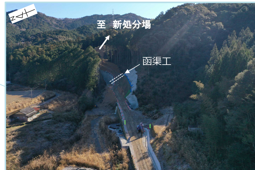
進入道路工事（空中写真、令和7年1月撮影）
