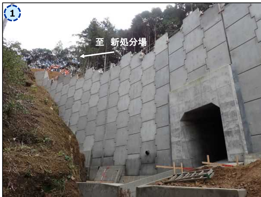
函渠と周辺の整備状況 (令和6年12月12日撮影)
