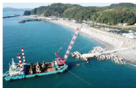
戸原工区 6号突堤施工状況
