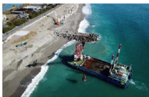
戸原工区 5号突堤施工状況
