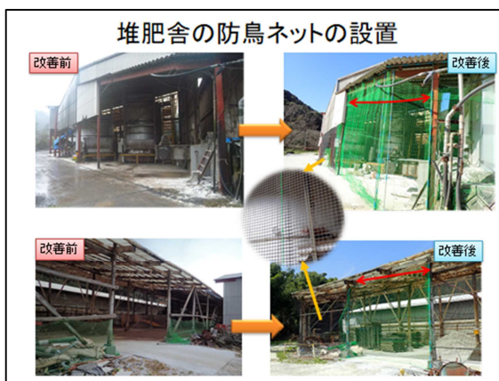
図4 防鳥ネットの設置
