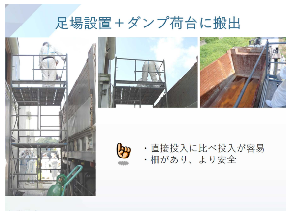
図 7 足場設置した上でダンプ荷台に搬出
