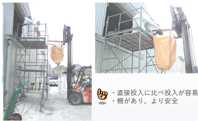
図 5 足場設置した上でフォークリフトで搬出
