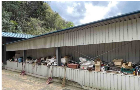
図5 倉庫裏（取組前）
