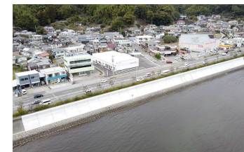
【高知港海岸】 （海岸堤防の耐震対策）
