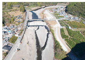
【安芸川】 （河川の堤防整備）
