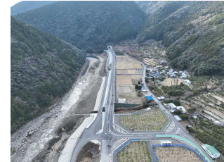
国道493号 (北川道路2-2工区)
