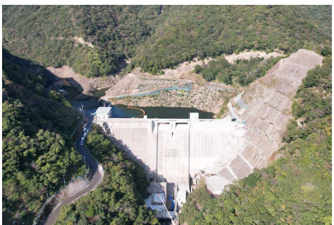
和食ダム建設
