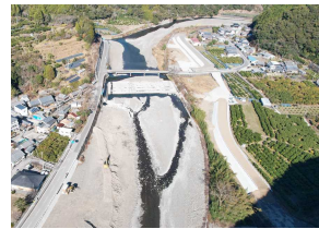
【安芸川】 (河川の堤防整備)
