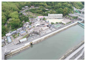
河川堤防の耐震対策
