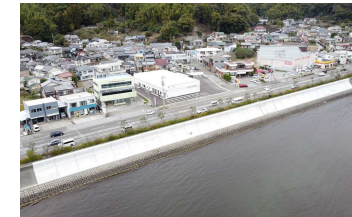
【高知港海岸】 (海岸堤防の耐震対策)
