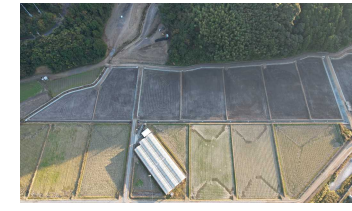
【志和地区(四万十町) ほ場整備】
