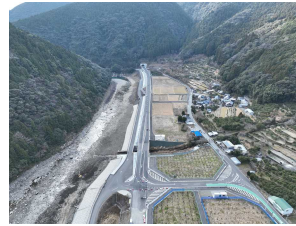
【北川道路 2-2工区】 (8の字ネットワークの整備)
