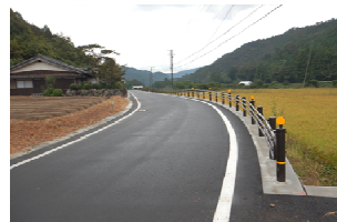
県道西土佐松野線における1.5車線の道路整備
