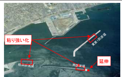
高知港防波堤の整備
