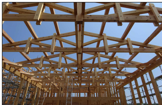
事業区分【3】木造化・木質化
