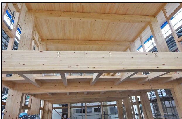
事業区分【3】木造化・木質化
