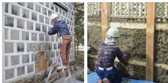
道具倉外壁の修理工事の様子
