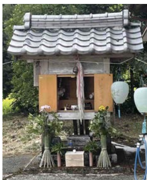
岩井口公民館の敷地にある不動堂
