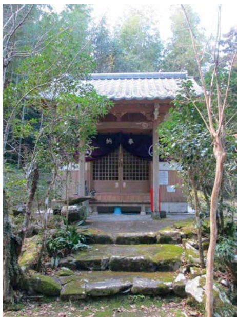
令和2年に改修された眞念庵堂舎
