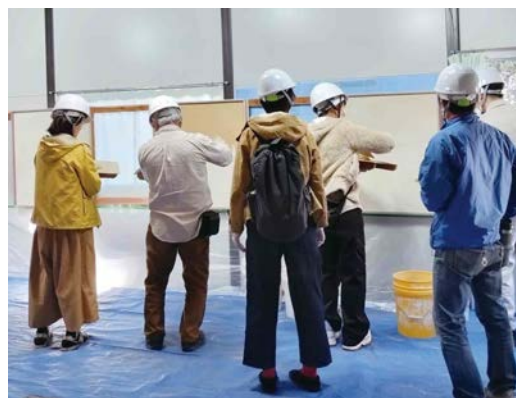
現場公開(土佐漆喰塗の体験中)
