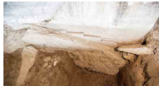
基礎下部には碎石代わりの川原石が敷き詰められている
