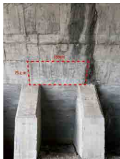
前部アーチのコンクリート基礎台と木製パネル痕
