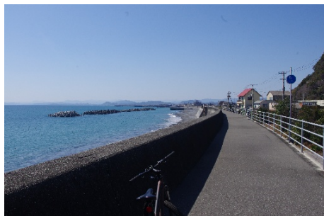
県道高知安芸自転車道 (香南市)
